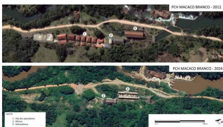
Figura 2- Identificação das edificações do conjunto arquitetônico (2012) e o estado atual (2024)
